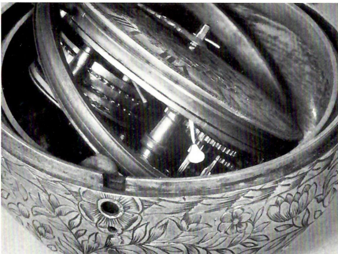
Fig. 4: Autre montre à pendule avec articulations de cardan non signée (allemande), vers 1680
